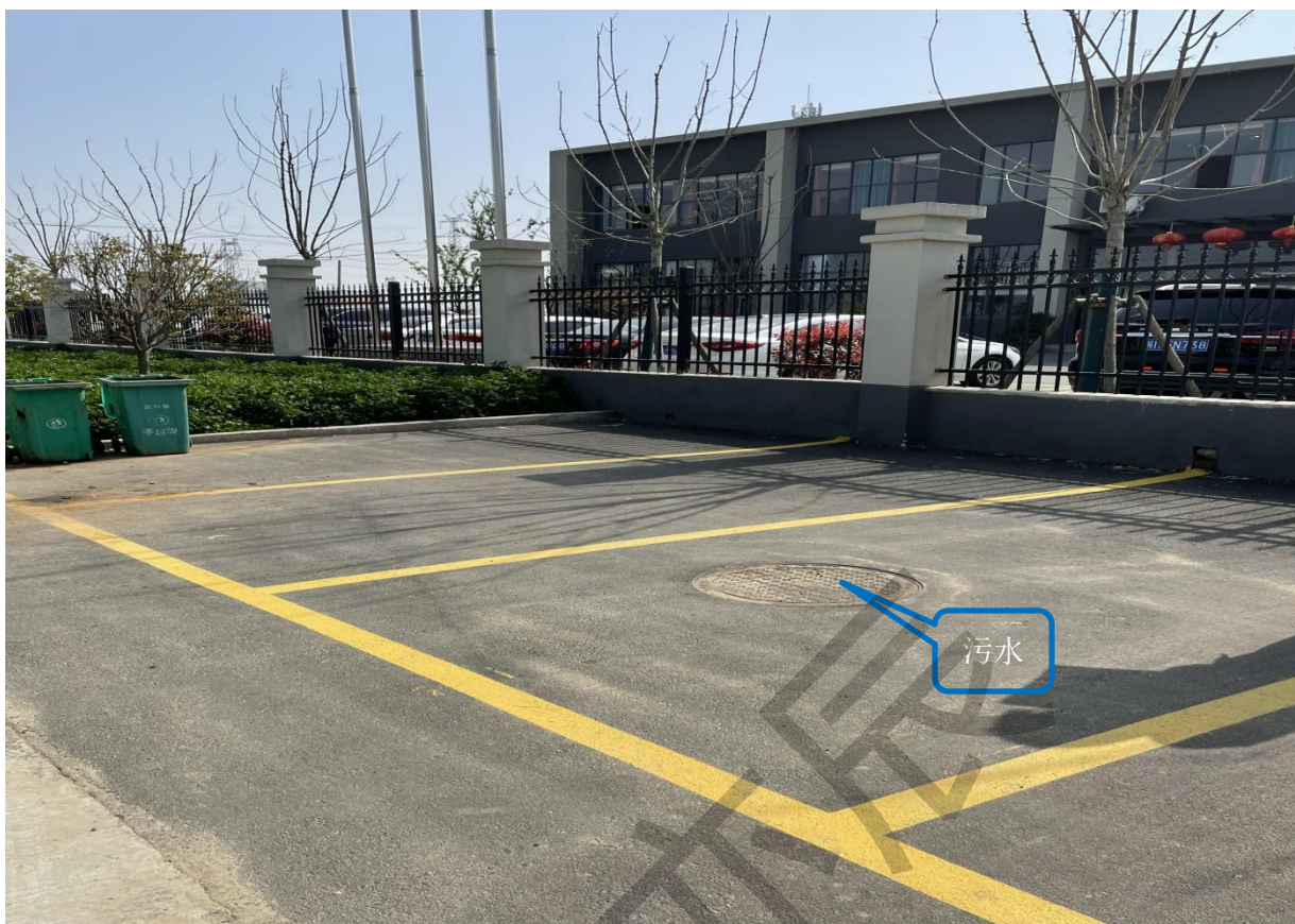
(污水总排水口)
